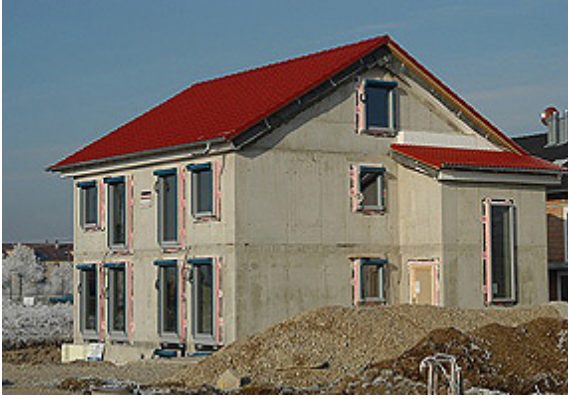
Unbewehrte Betonwände vom Keller bis zum Obergeschoss. Konsequenterweise entschieden sich Bauherr und Architekt auch bei der tragenden Dachkonstruktion für den Werkstoff Beton. Fotos: Alfred Rauhut
