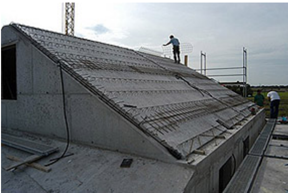
Unbewehrte Betonwände vom Keller bis zum Obergeschoss. Konsequenterweise entschieden sich Bauherr und Architekt auch bei der tragenden Dachkonstruktion für den Werkstoff Beton. Fotos: Alfred Rauhut
